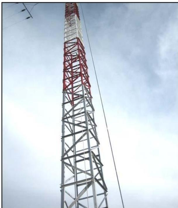
Aplicación de recubrimiento transparente VpCI-386 a toda la estructura metálica:
