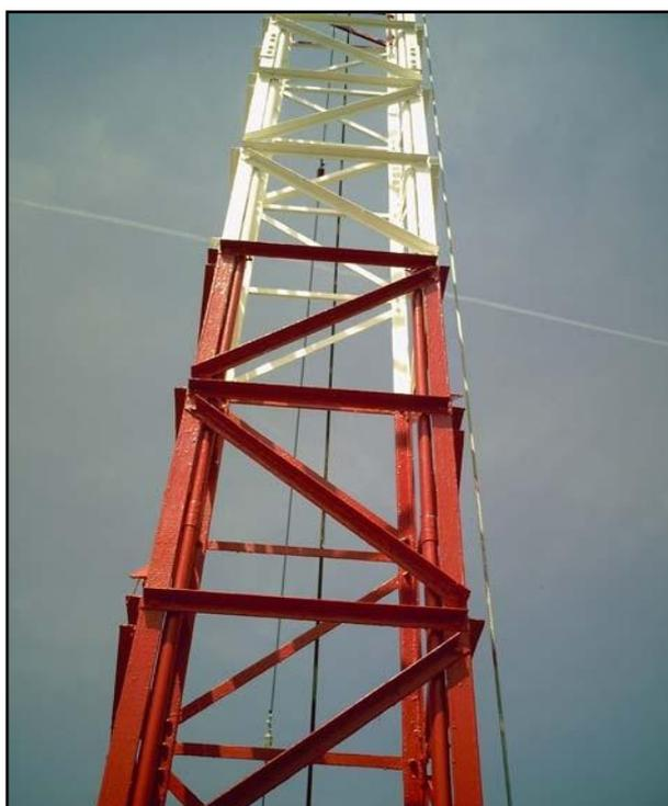
En las siguientes imágenes se puede comprobar de una manera comparativa el estado inicial de la estructura metálica y tras la aplicación de la protección anticorrosiva:
