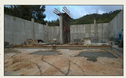
Una vez establecida el tipo de problemática existente y las consideraciones de potabilidad, se aditiva el inhibidor de corrosión MCI-2005, inhibidor de corrosión migratorio en base aminocarboxilato que protege las armaduras de hormigón embebidas frente a los ataques por cloruros y carbonatación, el producto se dosifica a razón de 0,6 l/m³ y cumple con la NSF Standard 61 para su uso en contacto con agua potable.
