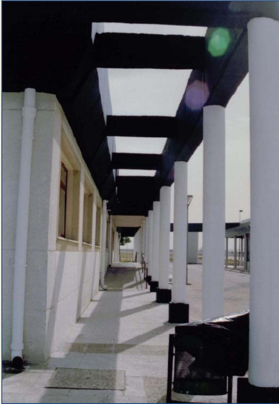
*Estado final de los pilares del edificio anexo a la torre de control una vez recubiertos con Q-2100.*
