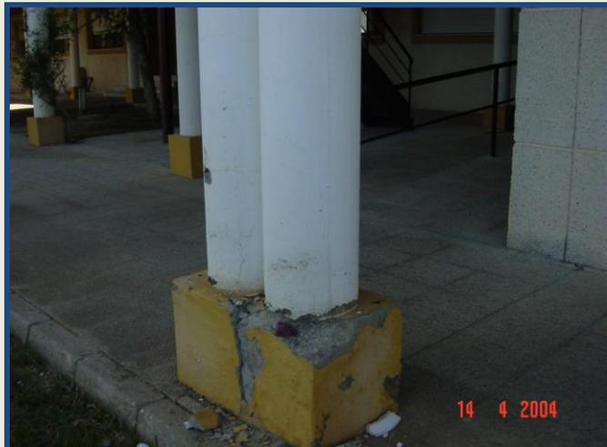
*Detalle del daño en los pilares*
