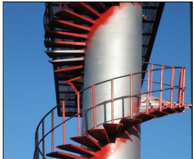
Aplicación de recubrimiento poliuretano alifático con inhibidores de corrosión en fase vapor VpCI Q-365:
