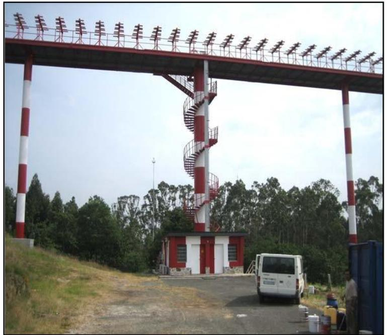
Finalmente se aplica a toda la estructura el recubrimiento transparente con inhibidores de corrosión en fase vapor VpCI-386:
